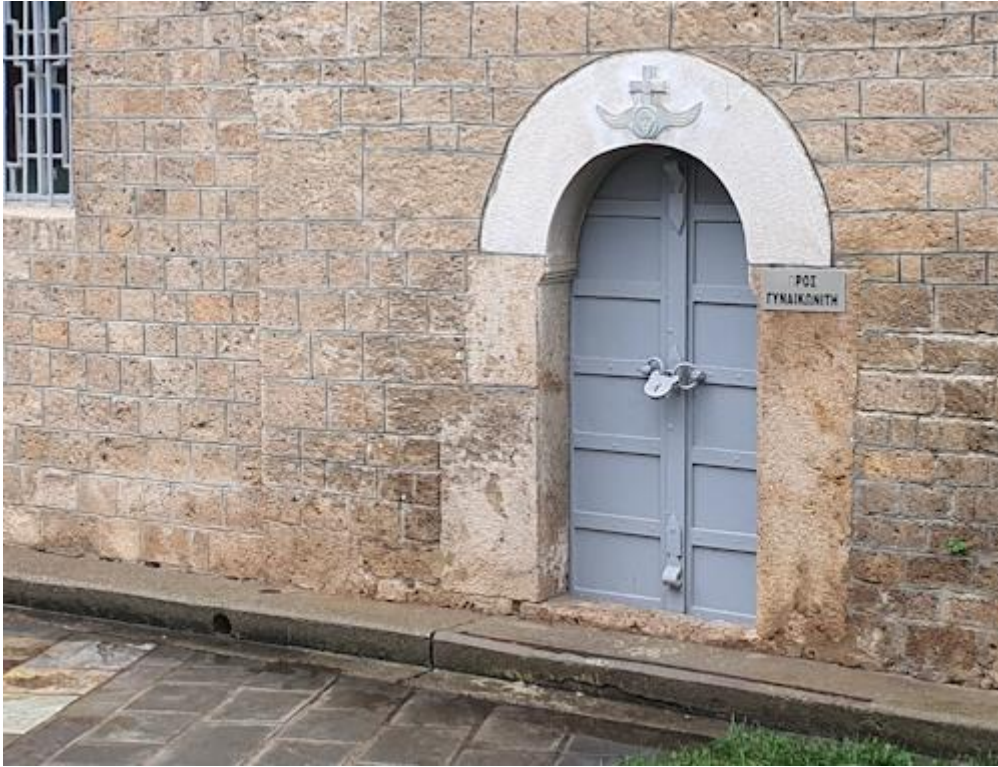
Εἰκ. 3-2. «Πρὸς γυναικωνίτην» (ὑπερῶν). Ξεχωριστὴ εἴσοδος γιὰ τοὺς ἄνδρες καὶ γιὰ τὶς γυναῖκες στὸν Ναόν. Τερὸς Ναὸς Ὁσίου Ἀντωνίου Βεροίας (1904), (Φωτ. ΠΔΠ, 2023).
